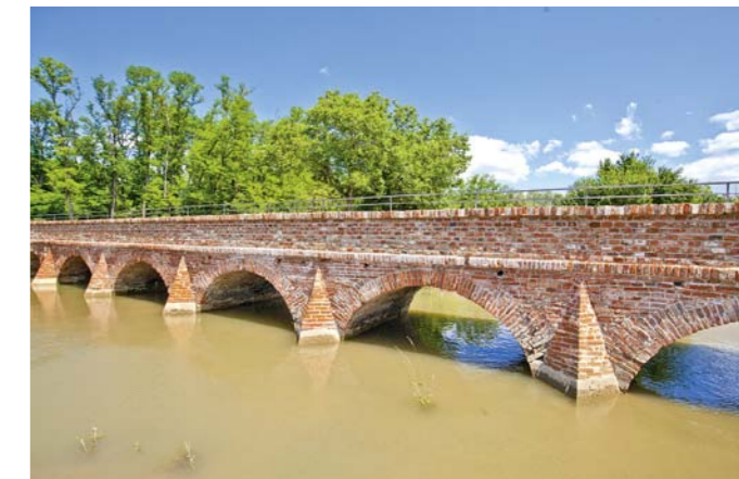
Nedávno obnovený barokní most u zámečku Portz
